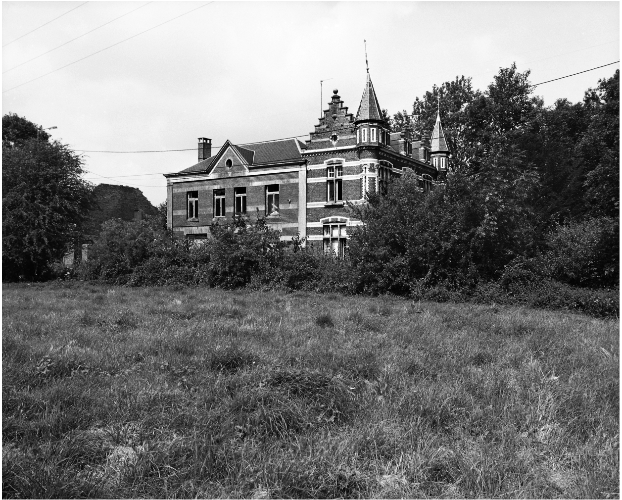
Vue générale des deux corps de logis.
