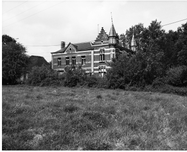
Vue générale des deux corps de logis. Phot. Thierry Petitberghien IVR31_20025901903X
