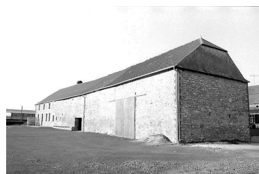
Elévation postérieure de la ferme. Phot. Xavier-Philippe Guiochon IVR22_19980202712Z
