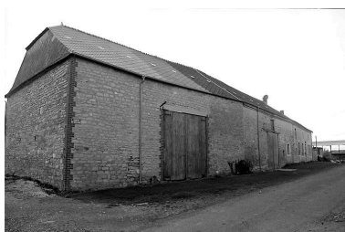
Vue générale. Phot. Xavier-Philippe Guiochon IVR22_19980202711Z
