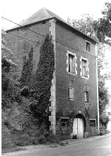
Tour du moulin (1ère moitié 19e siècle), 4 ruelle du Château. Phot. Xavier-Philippe Guiochon IVR22_19980201516Z
