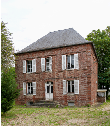
Ancien logement du directeur de l'usine (?), vue depuis l'ouest. Phot. Marc Kérignard IVR32_20246000680NUCA
