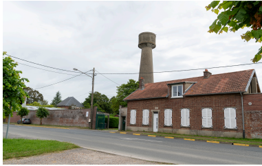
Entrée de l'usine, vue depuis la D1001. Phot. Marc Kérignard IVR32_20246000681NUCA
