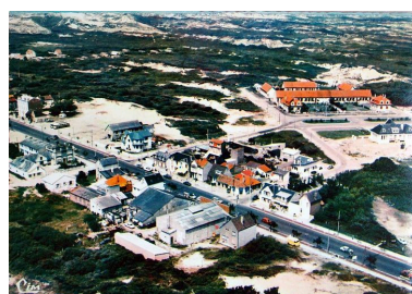
Vue aérienne, partie est de la station, avec la mairie et l'école, carte postale, 3e quart 20e siècle (coll. part.). Phot. Monnehay-Vulliet Marie-Laure IVR22_20048000100NUCAB
