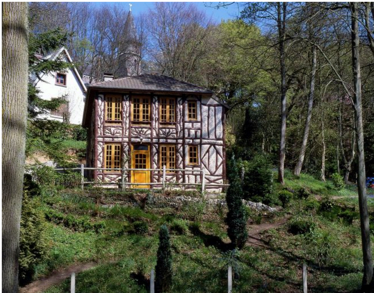
Vue d'ensemble après changement des huisseries.
