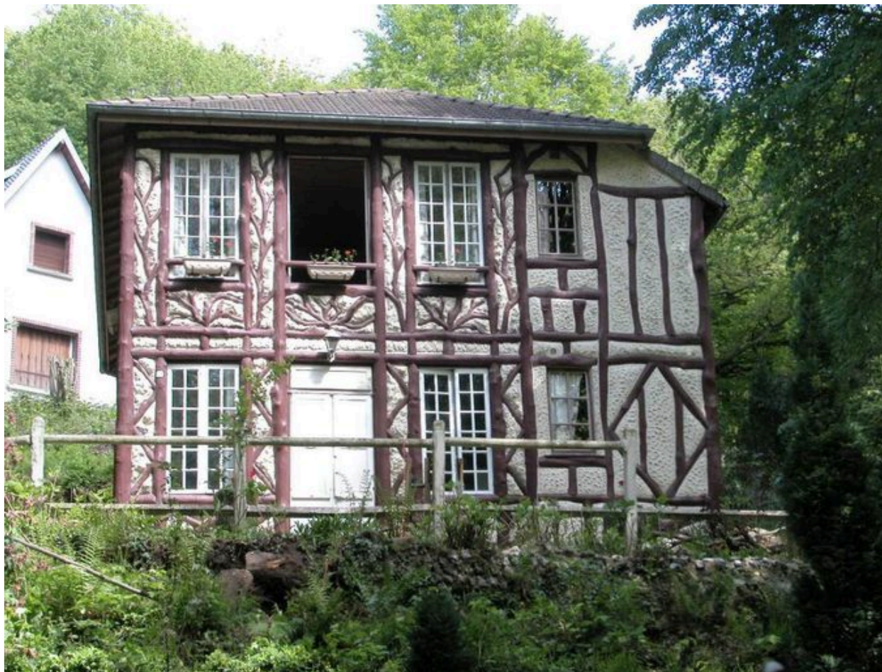
Vue d'ensemble avant changement des huisseries.
