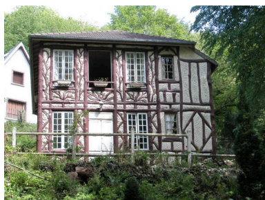
Vue d'ensemble avant changement des huisseries. Phot. Elisabeth Justome IVR22_20048001355NUCA
