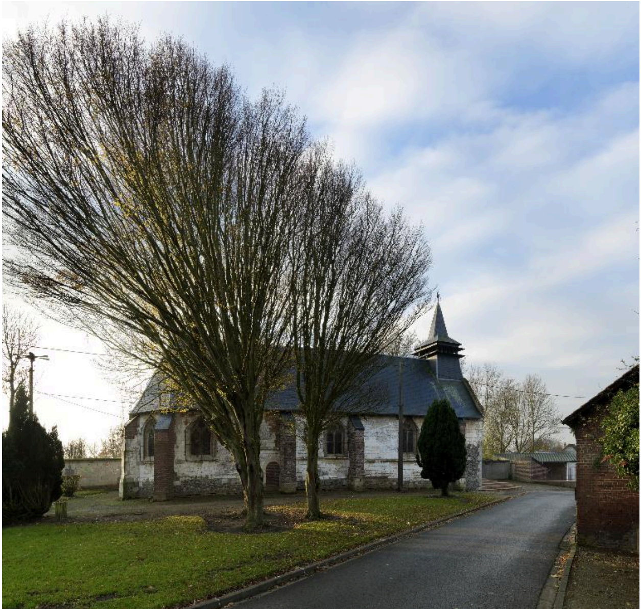
Vue générale nord-est.
