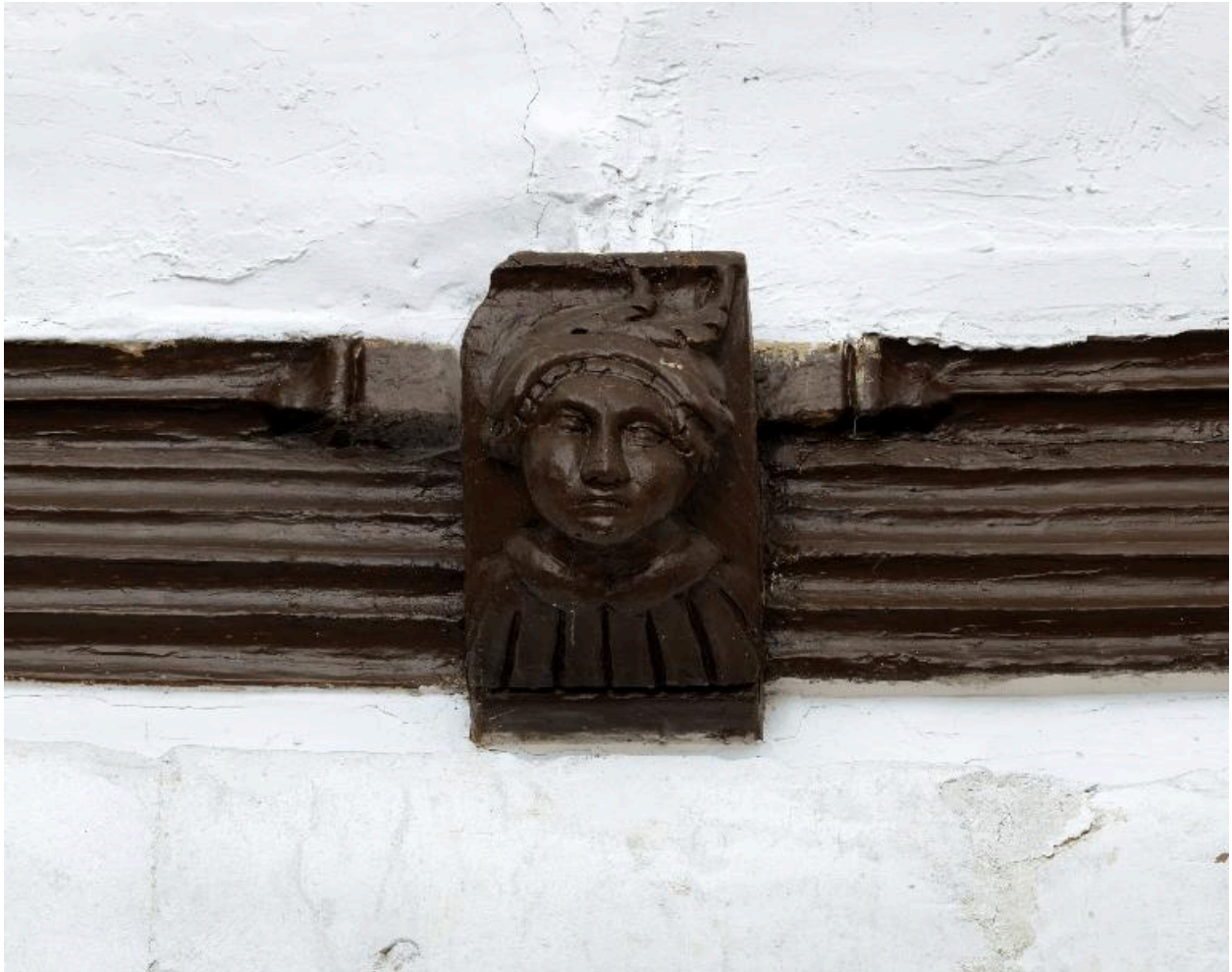
Détail d'un blochet.
