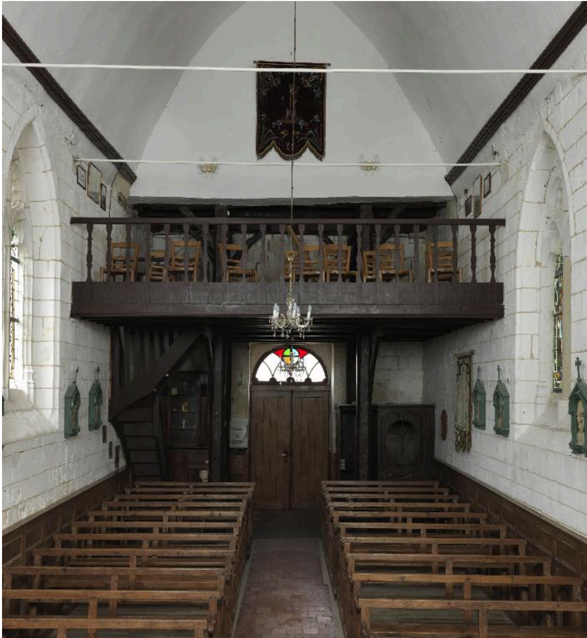
Vue de la nef depuis le chœur.
