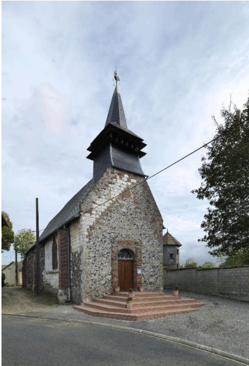
Vue de trois-quarts depuis la rue des Ecoliers.
