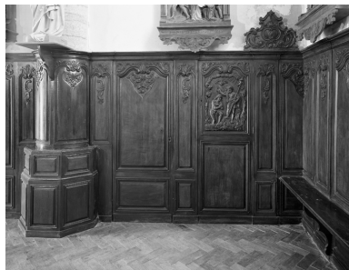
Les lambris de la nef et la porte des fonts baptismaux. Phot. Thierry Lefébure IVR22_19910200708V
