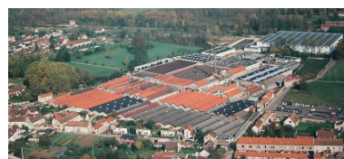
Vue aérienne de l'usine. Phot. Bertrand Fournier IVR22_20046003173NUCA
