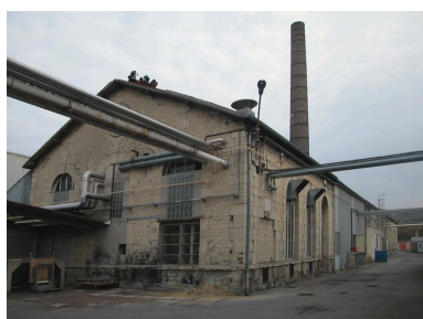
Atelier de fabrication avec la chaufferie en prolongement. Phot. Bertrand Fournier IVR22_20046003180NUCA
