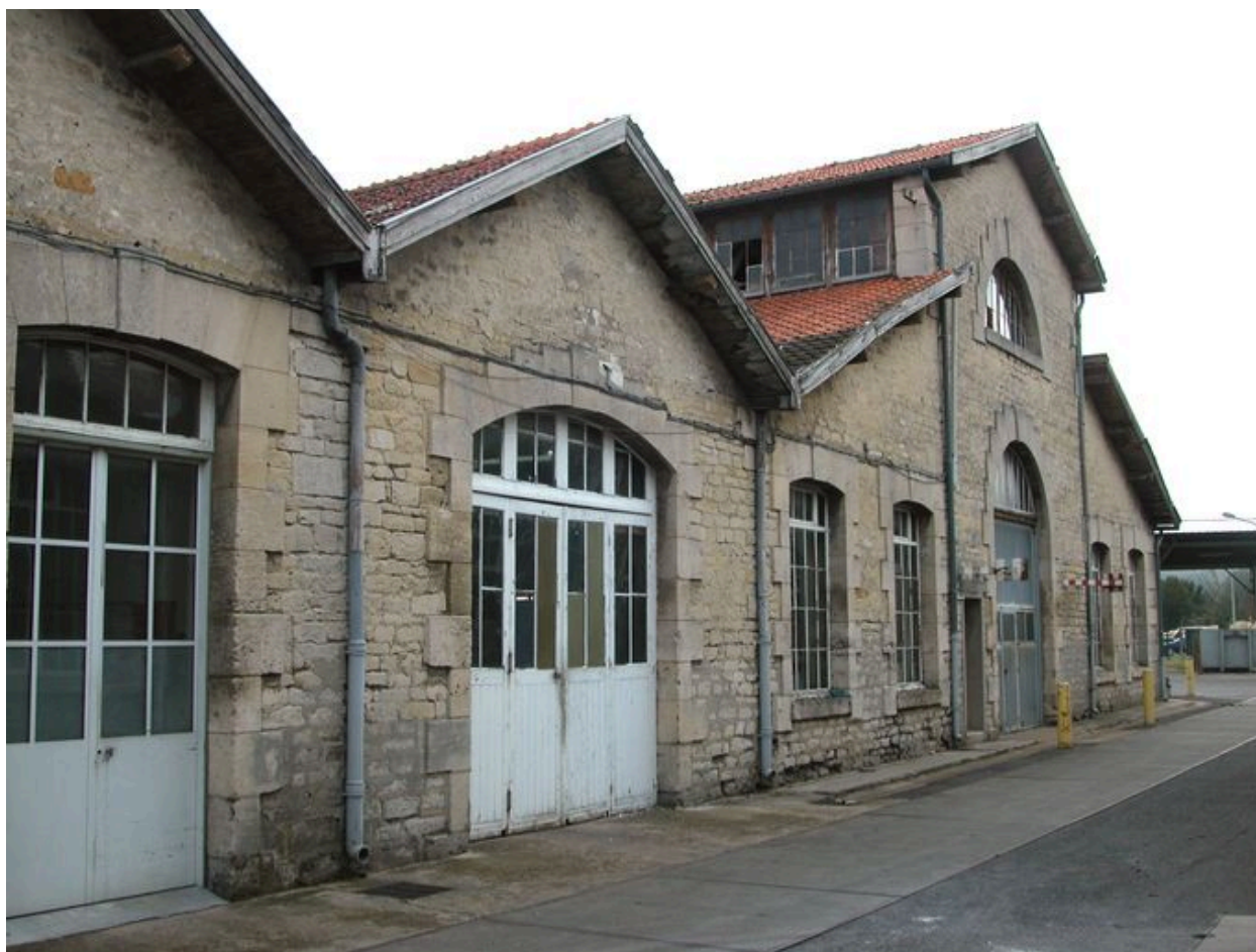
Magasin et atelier de mécanique.
