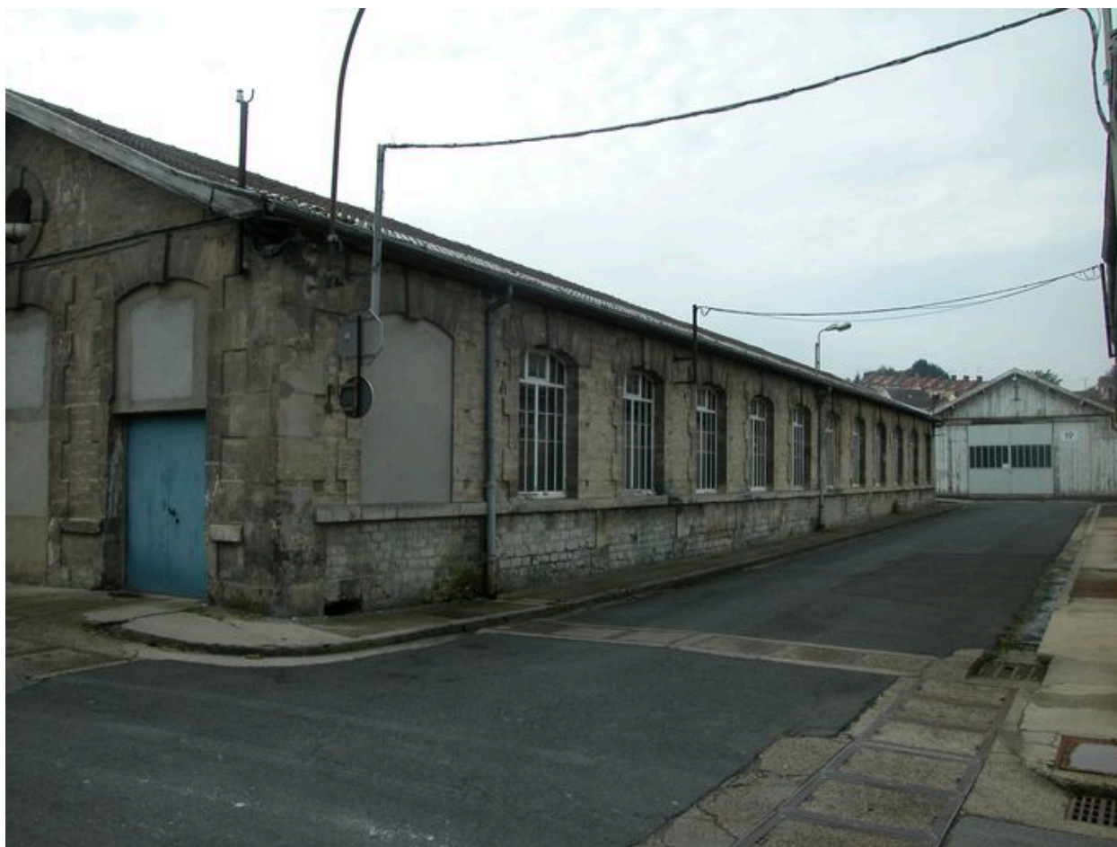
Façade longitudinale d'un des ateliers de fabrication.
