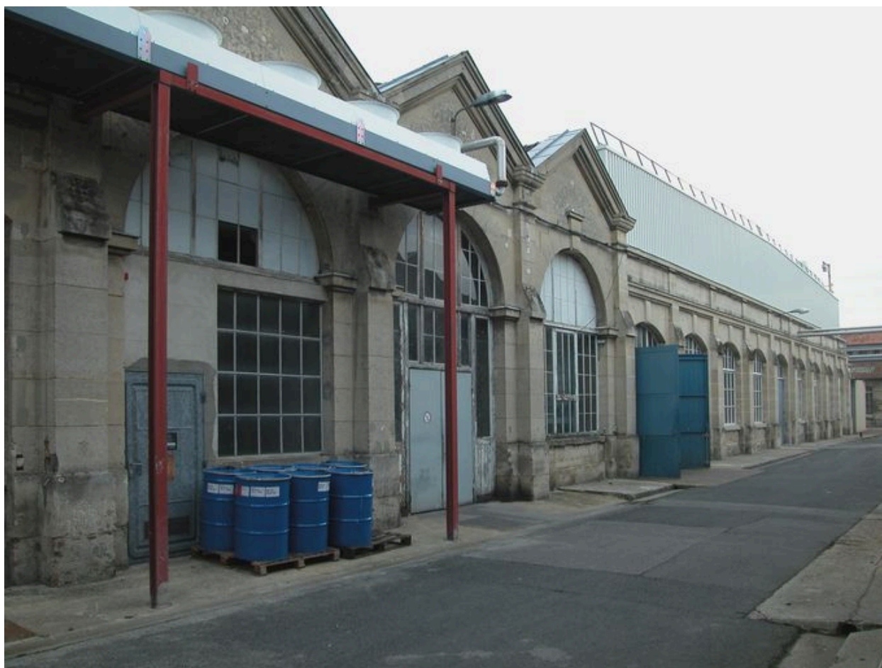
Vue partielle des ateliers de fabrication.
