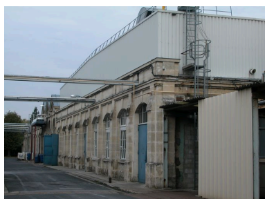
Vue partielle de l'atelier de fabrication principal, réhaussé en essentage de tôles nervurées. Phot. Bertrand Fournier IVR22_20046003177NUCA
