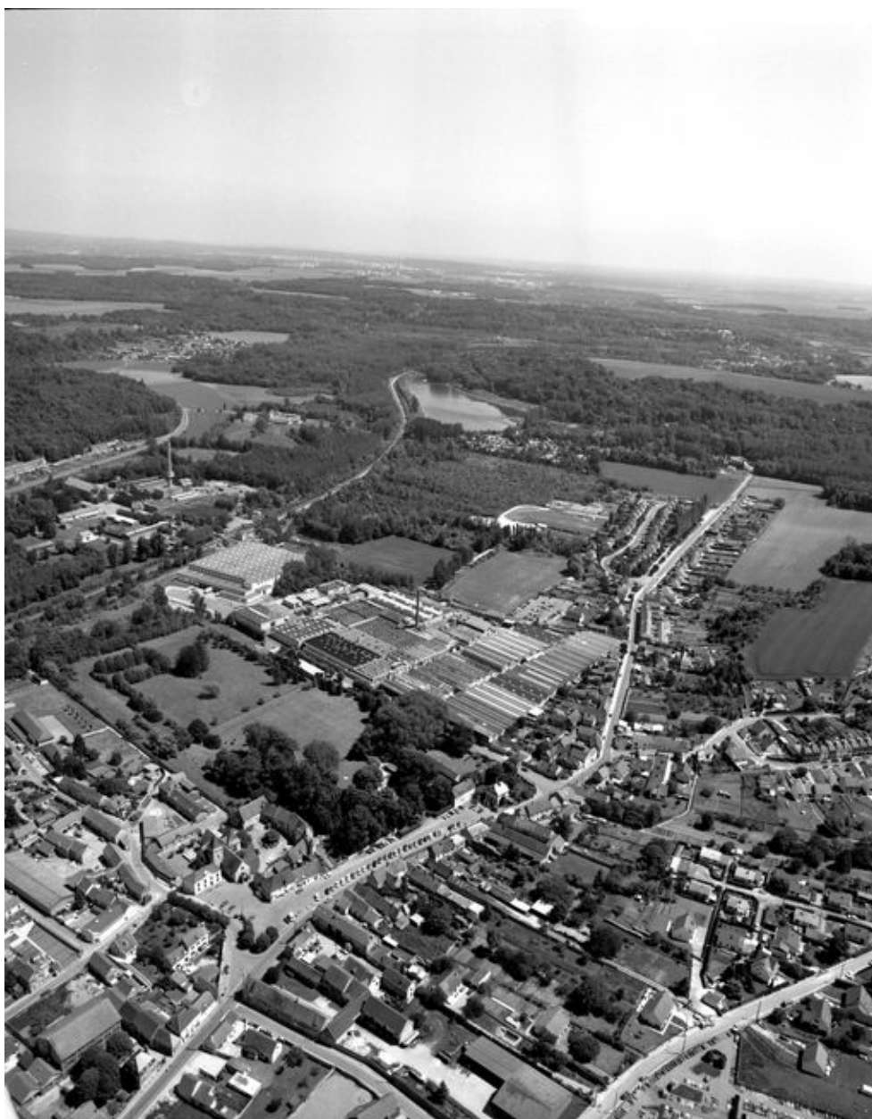
Vue aérienne de l'usine en 1995.
