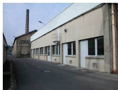
Atelier de fabrication moderne avec la chaufferie à l'arrière. Phot. Bertrand Fournier IVR22_20046003179NUCA
