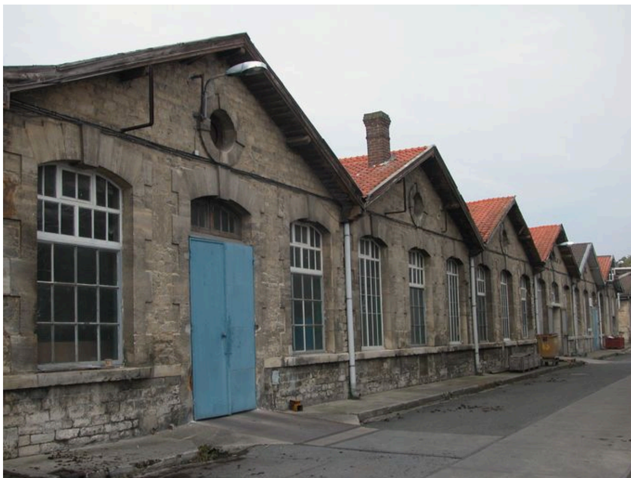
Succession des pignons des ateliers de fabrication.
