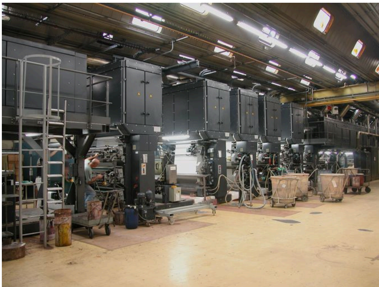
Vue d'ensemble d'une des chaînes de fabrication.
