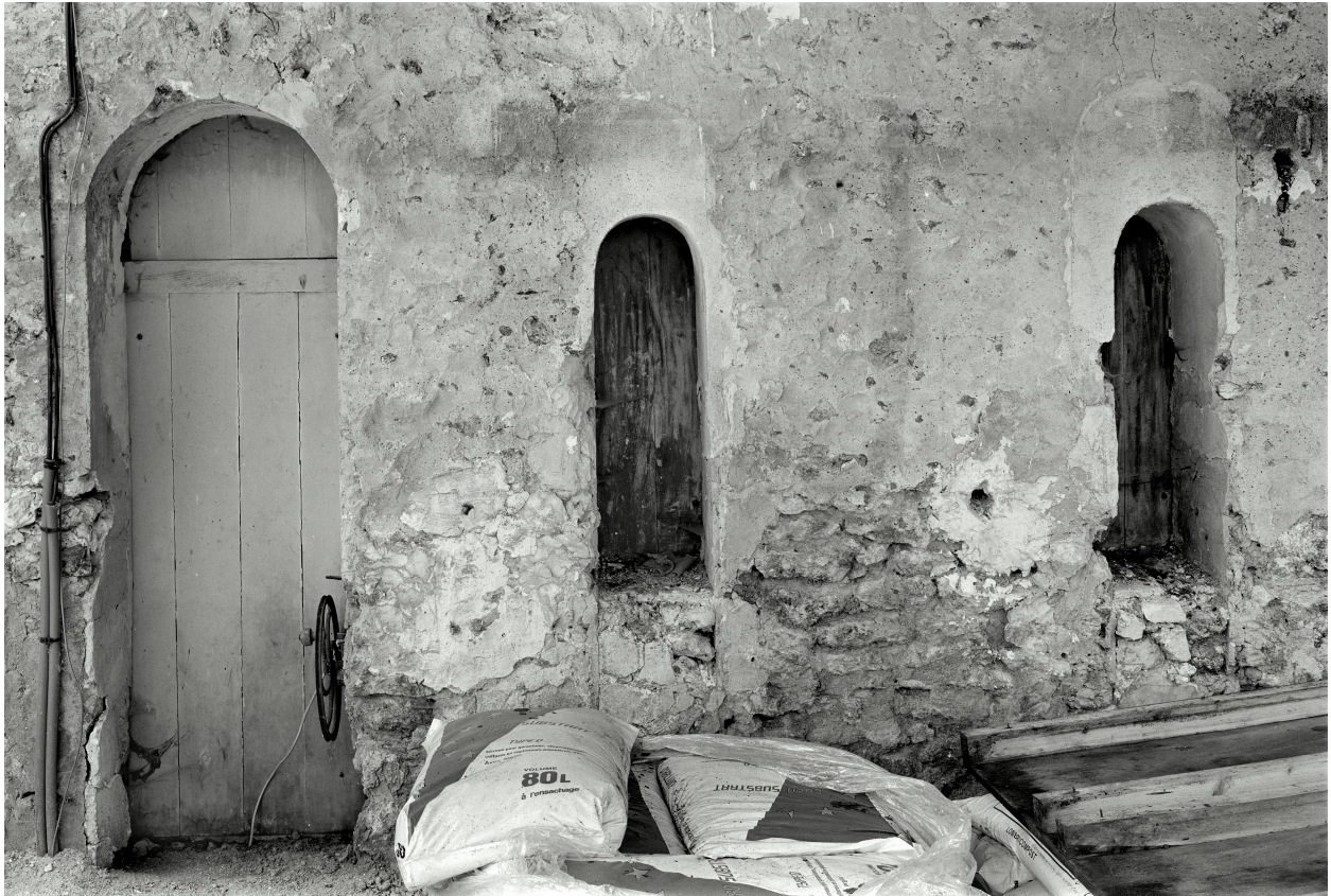
Détail des baies et de la porte arrière du bâtiment.
