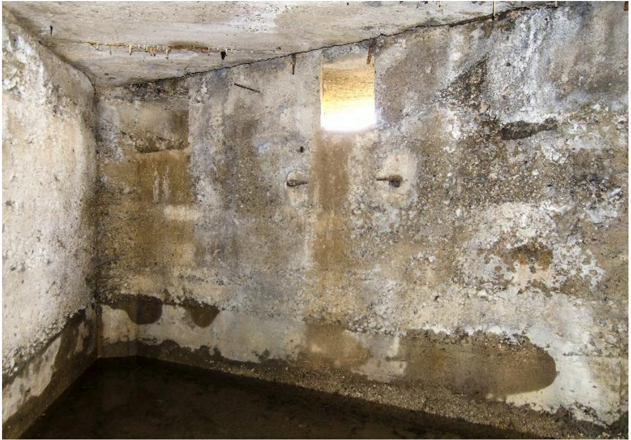
Vue intérieure. Partie gauche de l'abri. Embrasure de tir et, à sa gauche, embrasure d'observation
