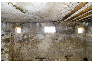
Vue intérieure, embrasures du mur nord-ouest. A la base de l'ouverture centrale, on note la présence de gonds. Ceux-ci atteste peut-être un chalit aujourd'hui disparu. Phot. Jean-Marc Ramette IVR32_20175900988NUCA
