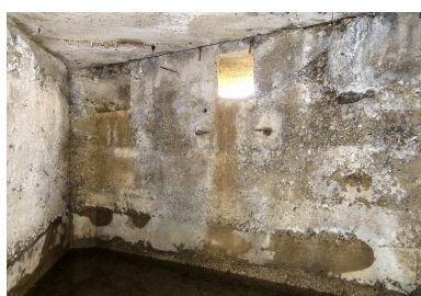
Vue intérieure. Partie gauche de l'abri. Embrasure de tir et, à sa gauche, embrasure d'observation Phot. Jean-Marc Ramette IVR32_20175900992NUCA
