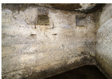
Vue intérieure. Partie droite de l'abri. Phot. Jean-Marc Ramette IVR32_20175900993NUCA
