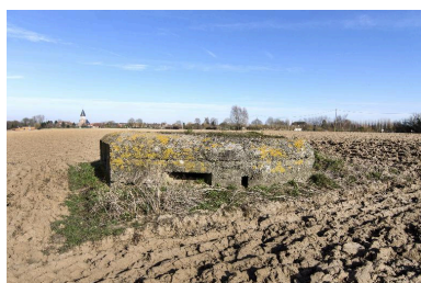
Vue latérale vers le nord-est. En arrière-plan l'église de Fromelles Phot. Jean-Marc Ramette IVR32_20175900985NUCA
