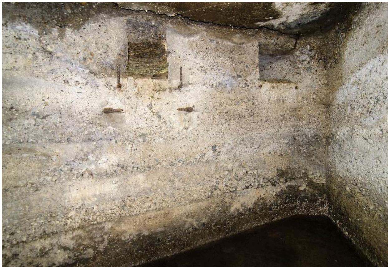
Vue intérieure. Partie droite de l'abri.
