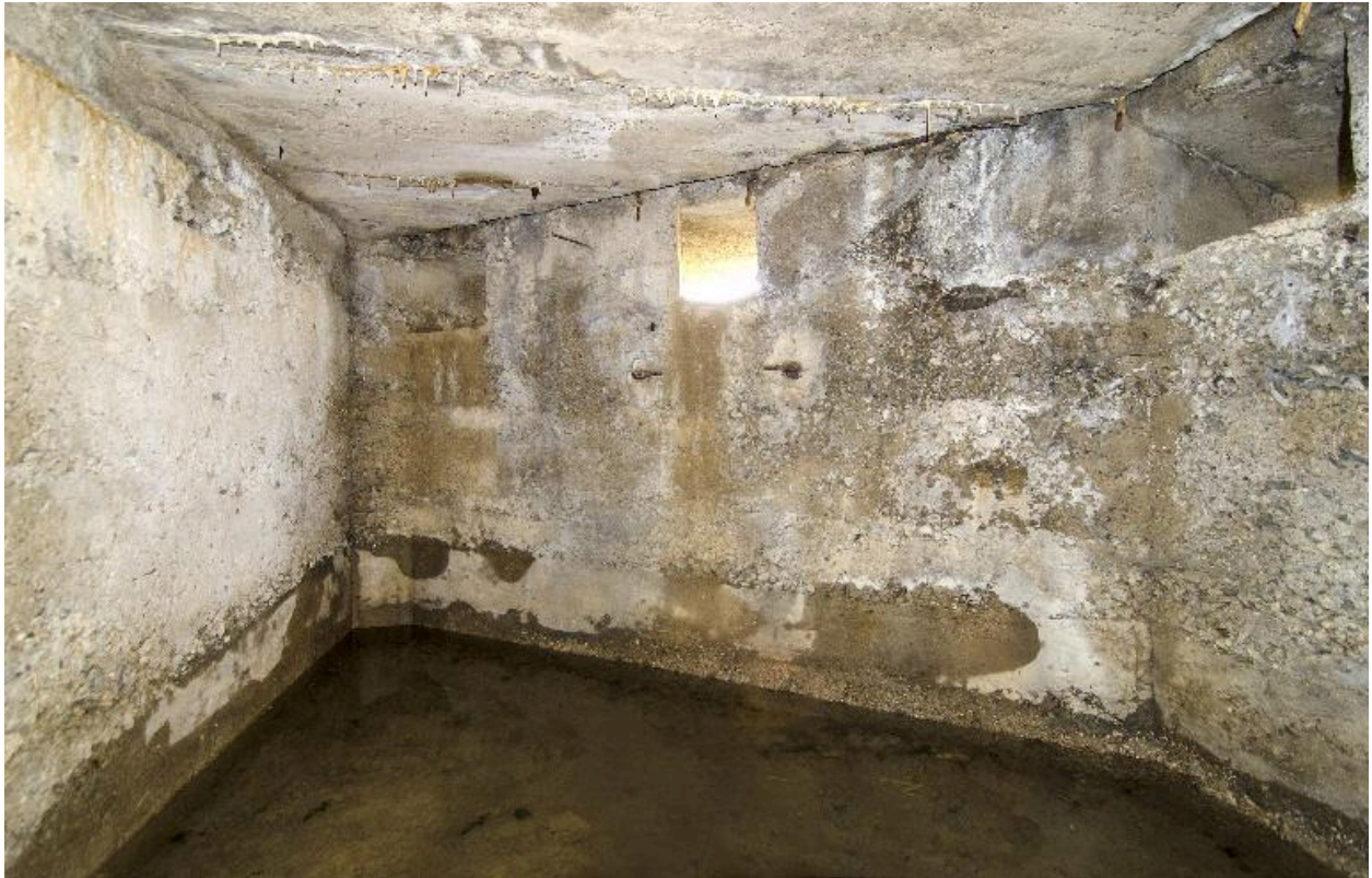
Vue intérieure. Partie gauche de l'abri au grand angulaire.
