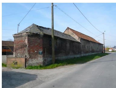
Vue sur les étables depuis la rue datées par les ancrs de 1900 et sur l'entrée principale. Phot. Inès Guérin IVR22_20058001611NUCA
