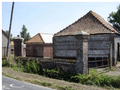
Vue sur l'angle sud-ouest de l'ensemble avant la destruction des bâtiments. Phot. Catherine Fourmond IVR22_20058001609NUCA
