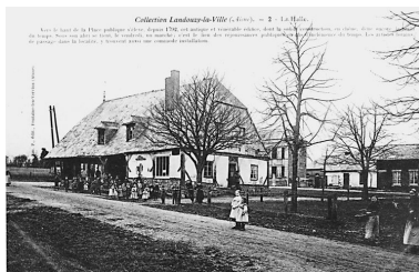
Vue depuis le sud-est de la halle démontée en 1923. (AP). Phot. Laurent Jumel (reproduction) IVR22_19970201306ZB
