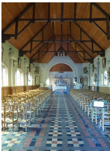
Vue intérieure de la nef vers le chœur.
