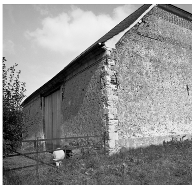
Grange : élévations externes depuis l'ouest. Phot. Thierry Lefébure IVR22_19960200633X
