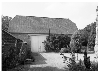
Grange : élévation sur cour. Phot. Thierry Lefébure IVR22_19960200631X
