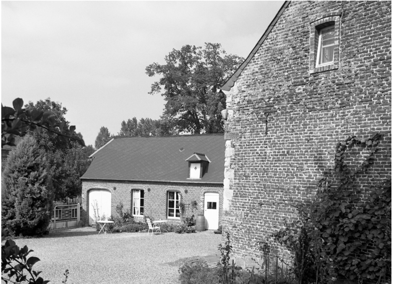
Anciennes étables : élévation sur cour.
