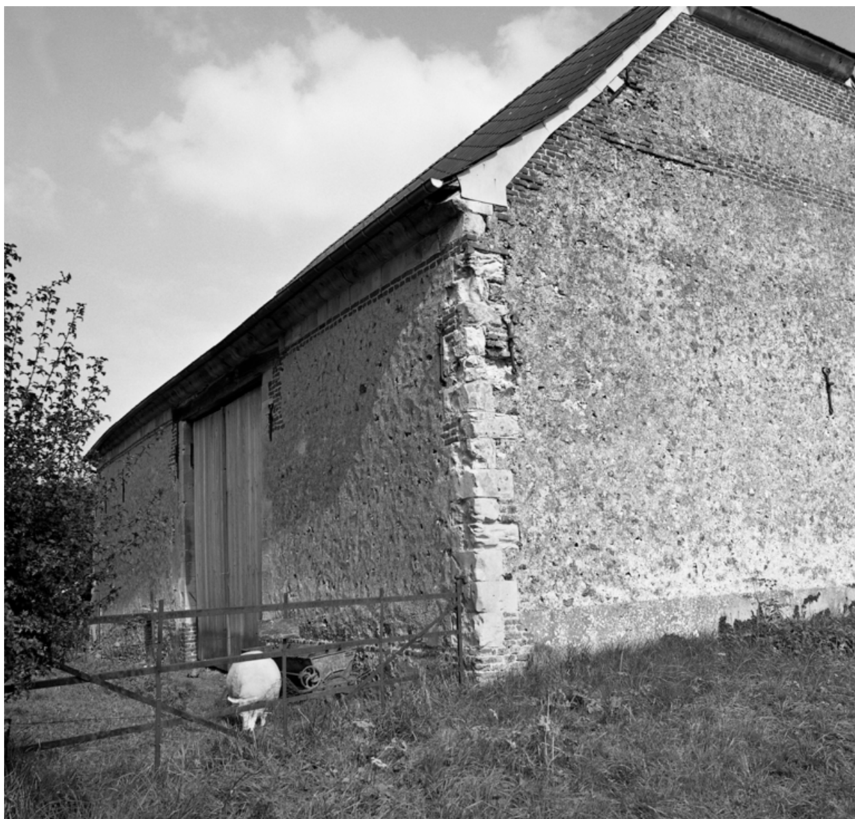
Grange : élévations externes depuis l'ouest.
