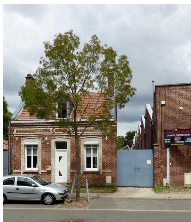
Logement (ancienne conciergerie ?). Phot. Isabelle Barbedor IVR32_20208005270NUCA
