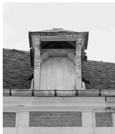
Détail d'une lucarne. Phot. Fabrice Charrondière IVR22_19866000068X
