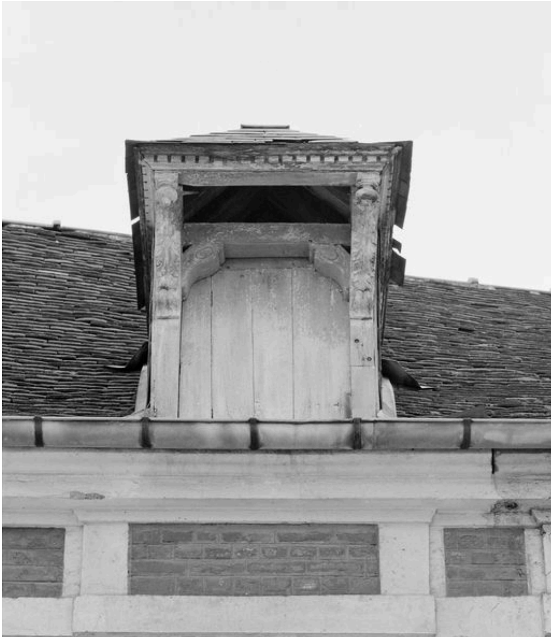
Détail d'une lucarne.
