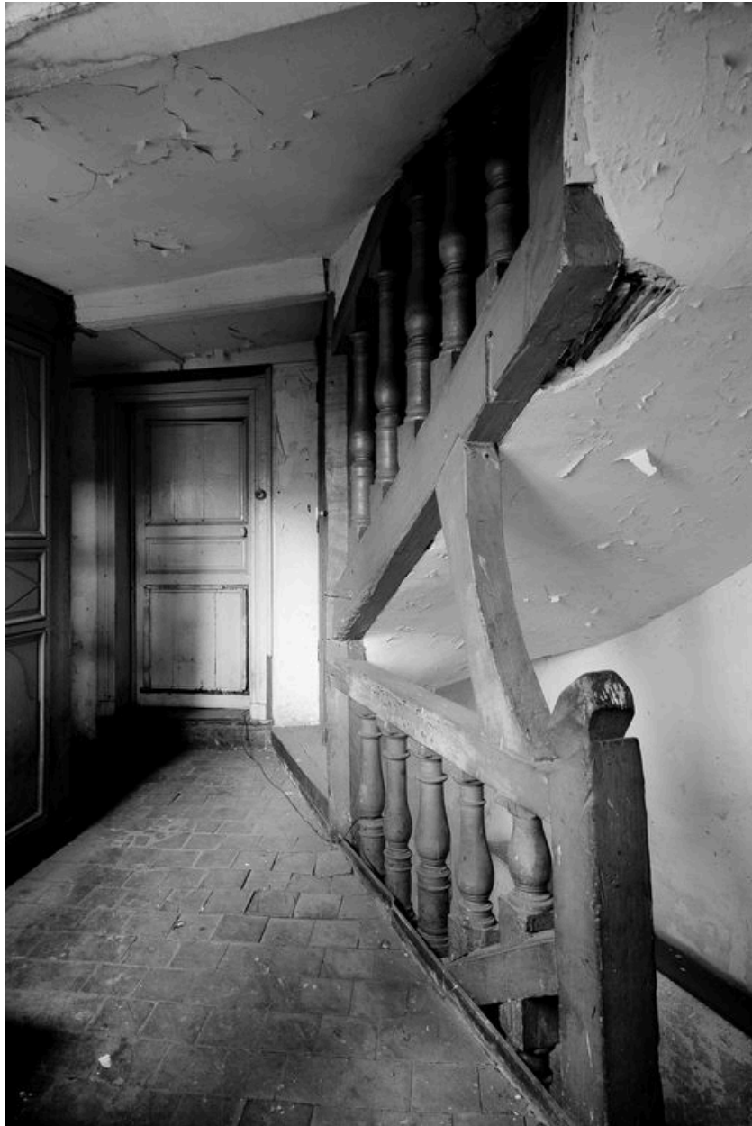
Vue intérieure : détail de l'escalier.
