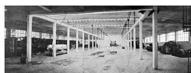
Ateliers en cours de reconstruction, 1921 (L'Aisne - L'illustration Economique et Financière). Repro. Frédéric Pillet IVR22_20060205353NUCAB
