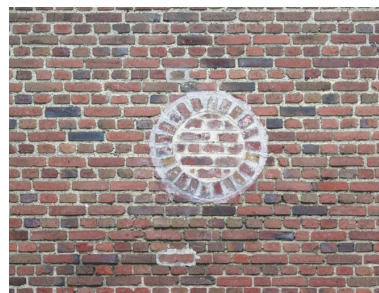
Maçonnerie de brique et ancien oculus. Phot. Frédéric Pillet IVR22_20070205018NUCA
