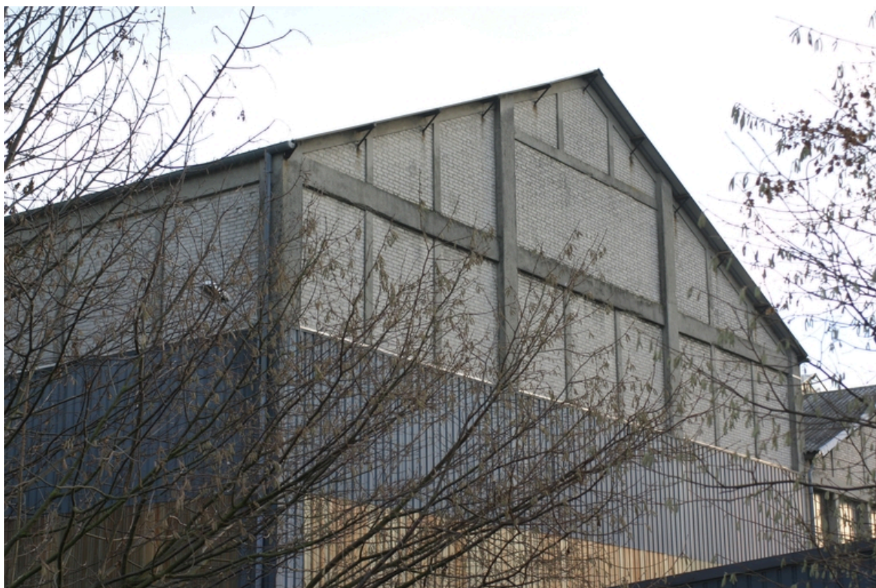
Pignon de l'une des deux halles.
