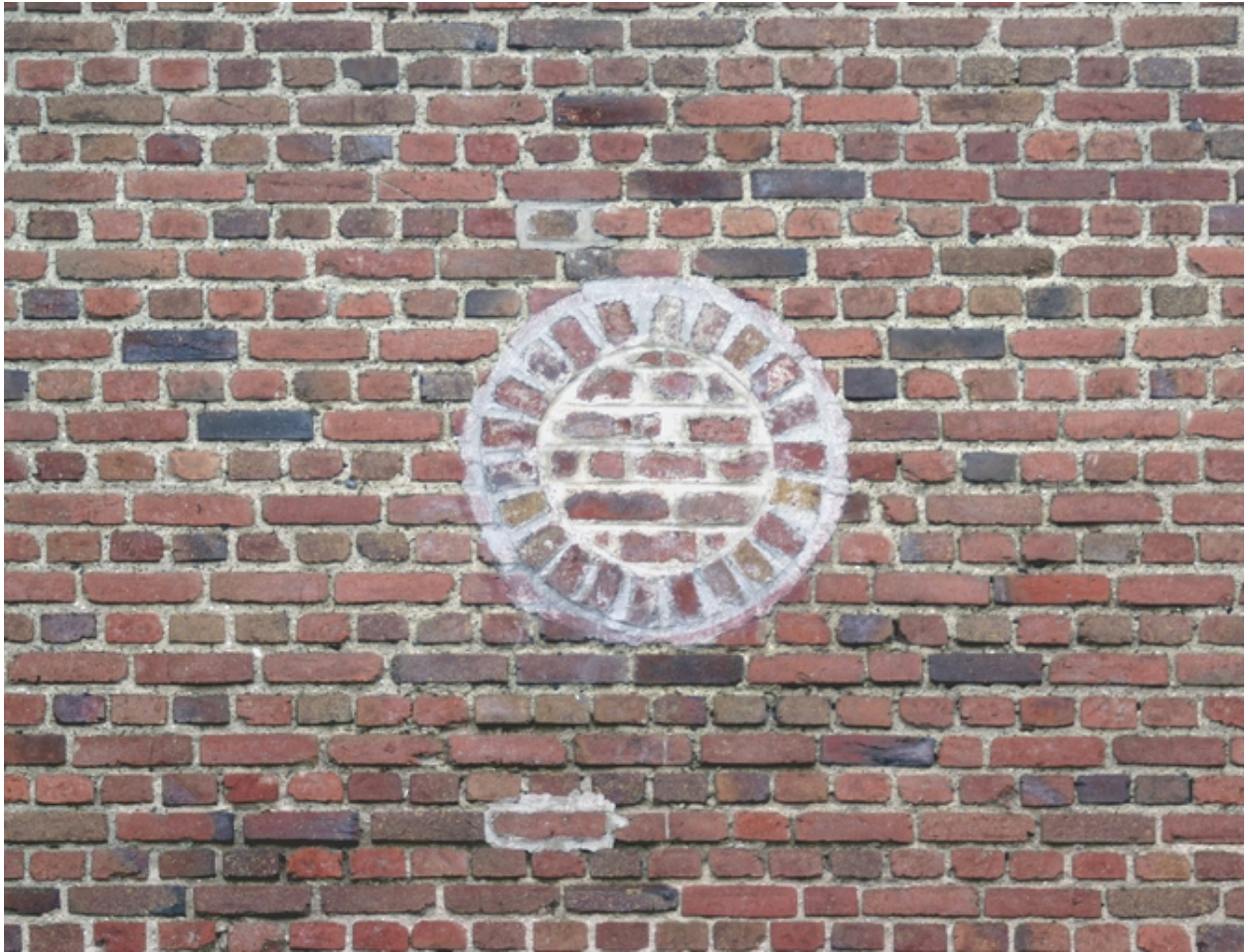
Maçonnerie de brique et ancien oculus.
