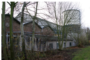
Ateliers et silo vus depuis le canal de Saint-Quentin. Phot. Frédéric Pillet IVR22_20070205016NUCA
