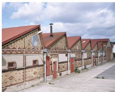
Enfilade de sheds de l'ancienne usine des 100 000 chemises à Creil.
