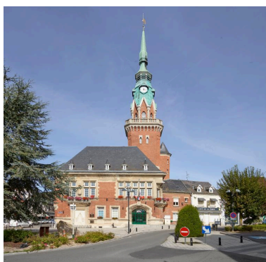
Façade sur la place Faidherbe. Phot. Hubert Bouvet IVR32_20196200447NUC4A
