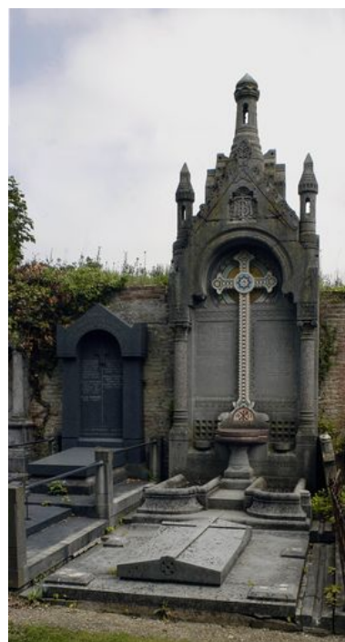
Tombeau des familles Thuillez-Mastifas-Bouchez-Dupuis. Phot. Thierry Lefebure IVR22_20058001345NUCA
