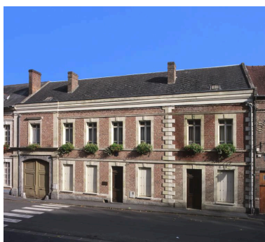
Vue de la partie droite du logis sur la rue Chantraine. Phot. Thierry Lefébure IVR22_20020201151XA
