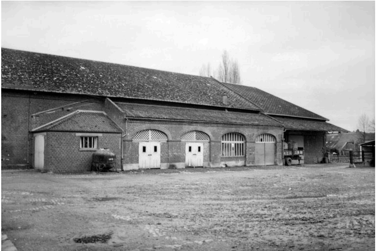
Vue de l'étable, située dans la cour, en bordure du boulevard Jean-Jaurès.
