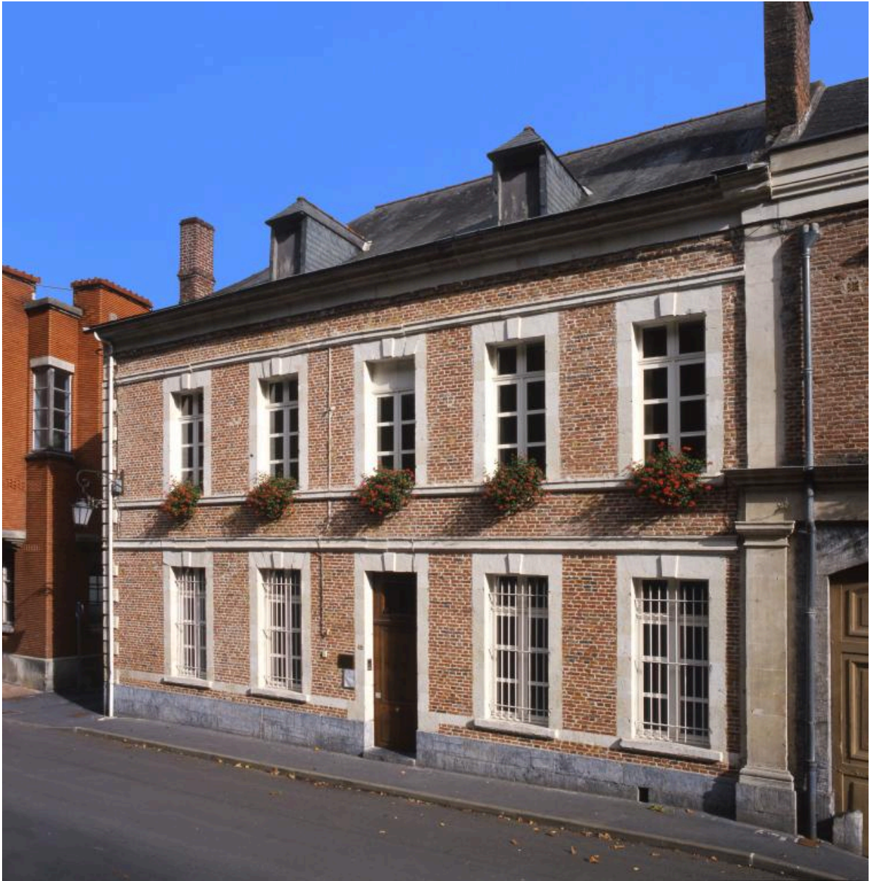
Vue de la partie gauche du logis sur la rue Chantraine.
