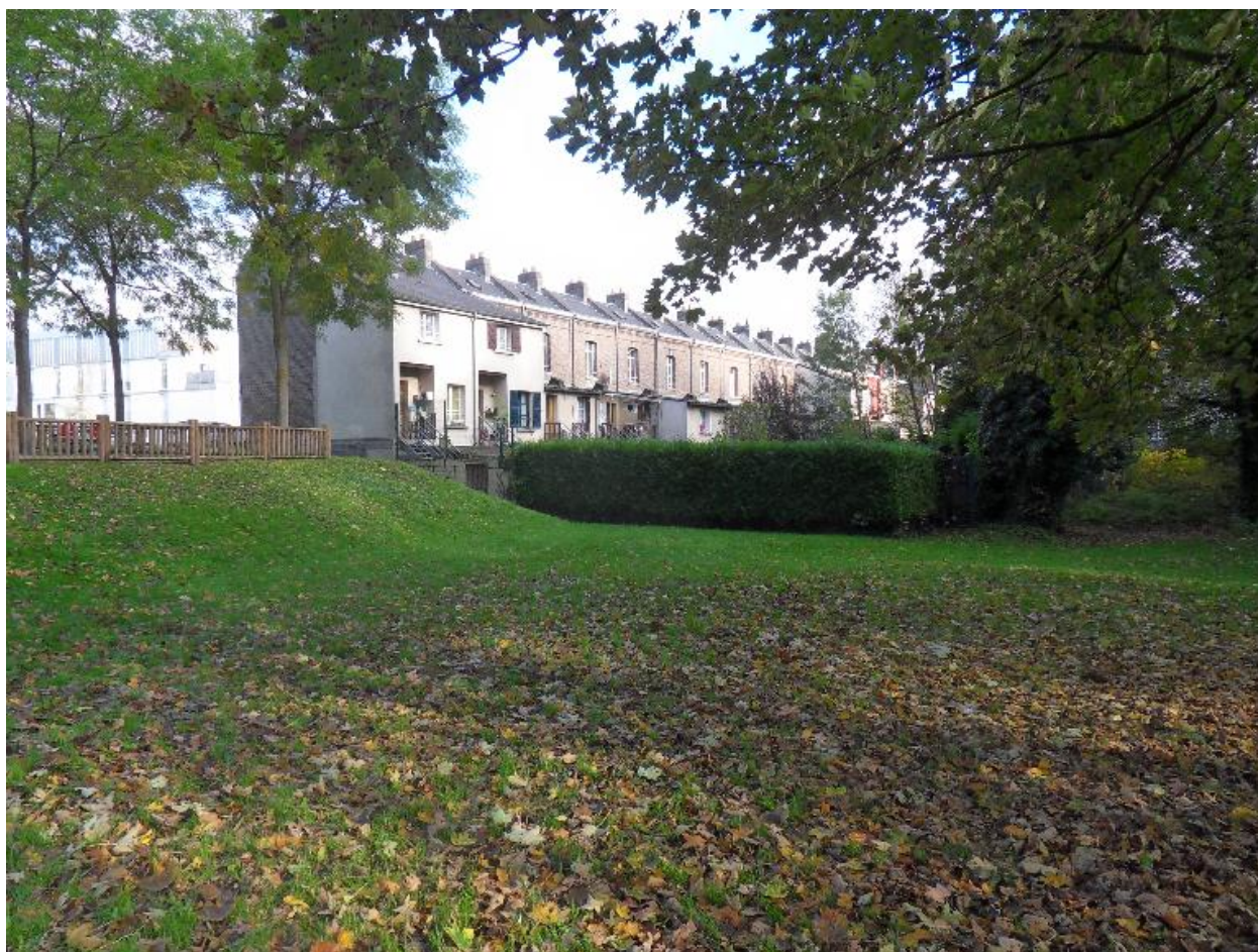
Vue des façades arrières des logements.
