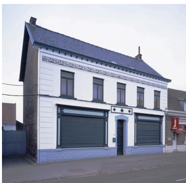
Vue générale. Phot. Pierre Thibaut IVR31_20095901336VA
