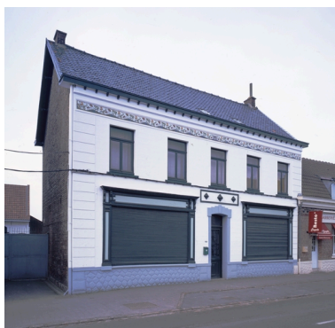
Vue générale. Phot. Pierre Thibaut IVR31_20095901336VA
