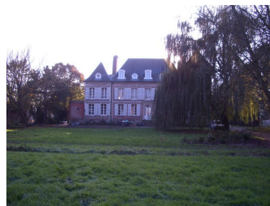
Vue postérieure du château. Phot. Inès Guérin IVR22_20058005197NUCA
