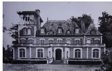
Vue ancienne du château. Phot. Inès Guérin IVR22_20058005189NUCAB
