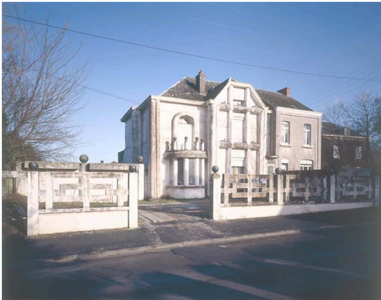
Élévation antérieure depuis la rue.
