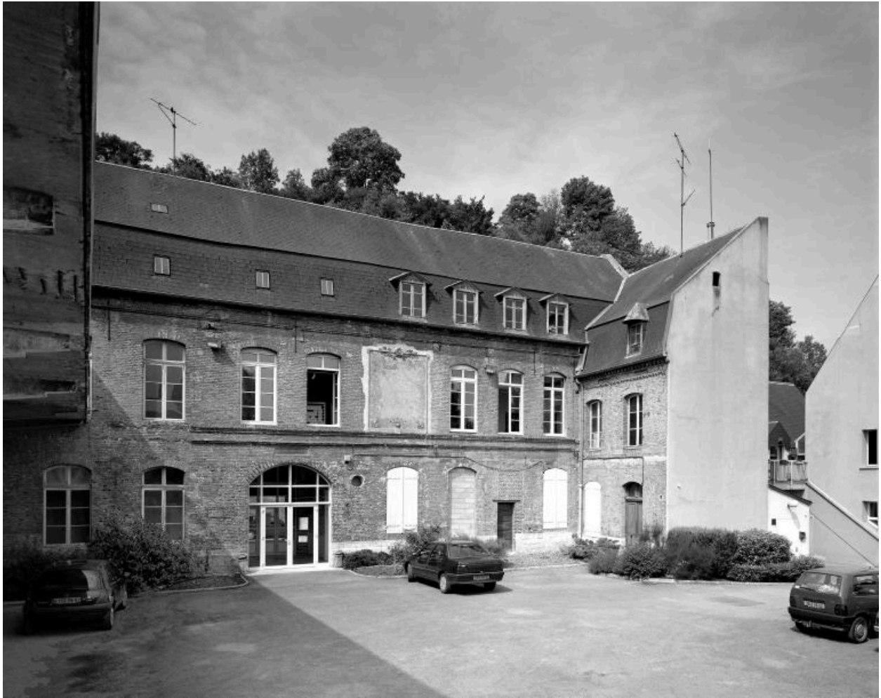
Vue des façades sur cour de l'ancien bailliage ducal.
