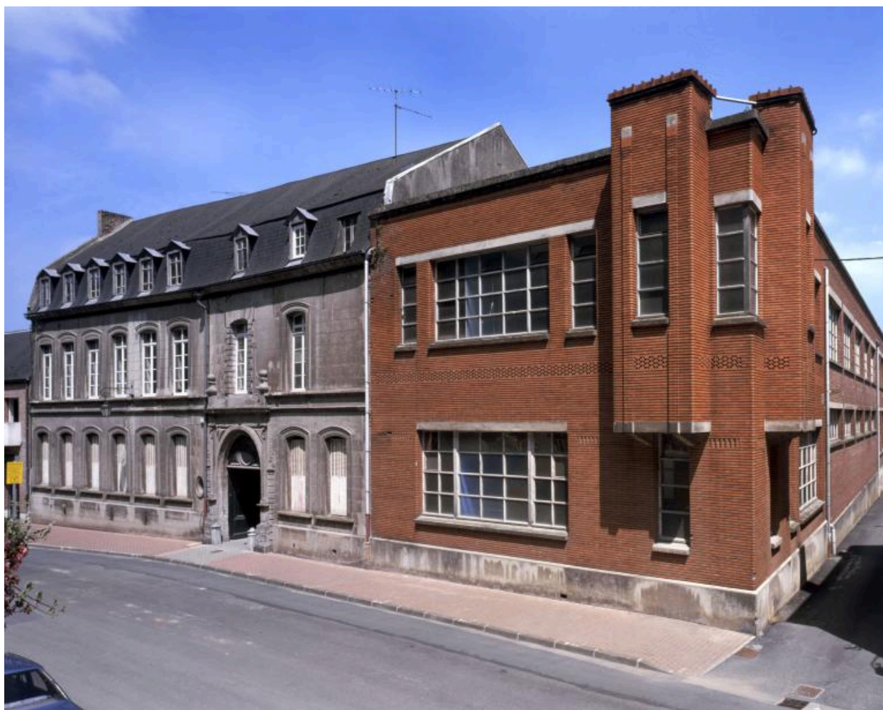
Vue générale de la façade sur rue de l'ancien bailliage ducal, flanquée, à droite, du bâtiment de brique construit en 1936 par Jean Canonne à l'emplacement de l'hôtel de ville détruit.
