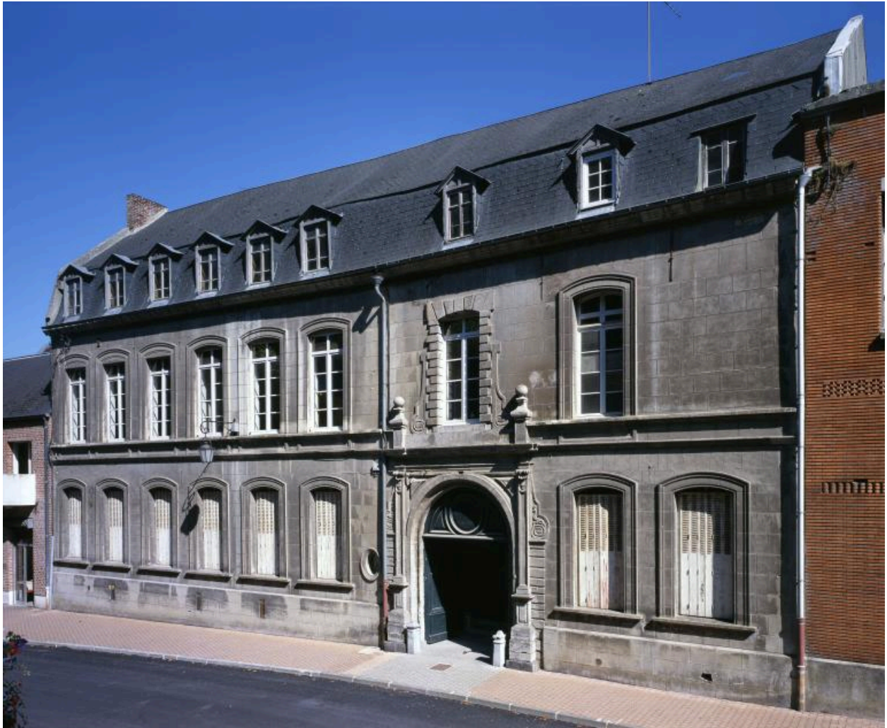
Vue de la façade sur rue de l'ancien bailliage ducal.
