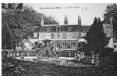
Vue ancienne de la villa avant la Première Guerre mondiale. Phot. Inès Guérin IVR22_20058005437NUCAB
