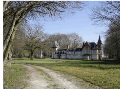
Vue générale. Phot. Inès Guérin IVR22_20058005293NUCA
