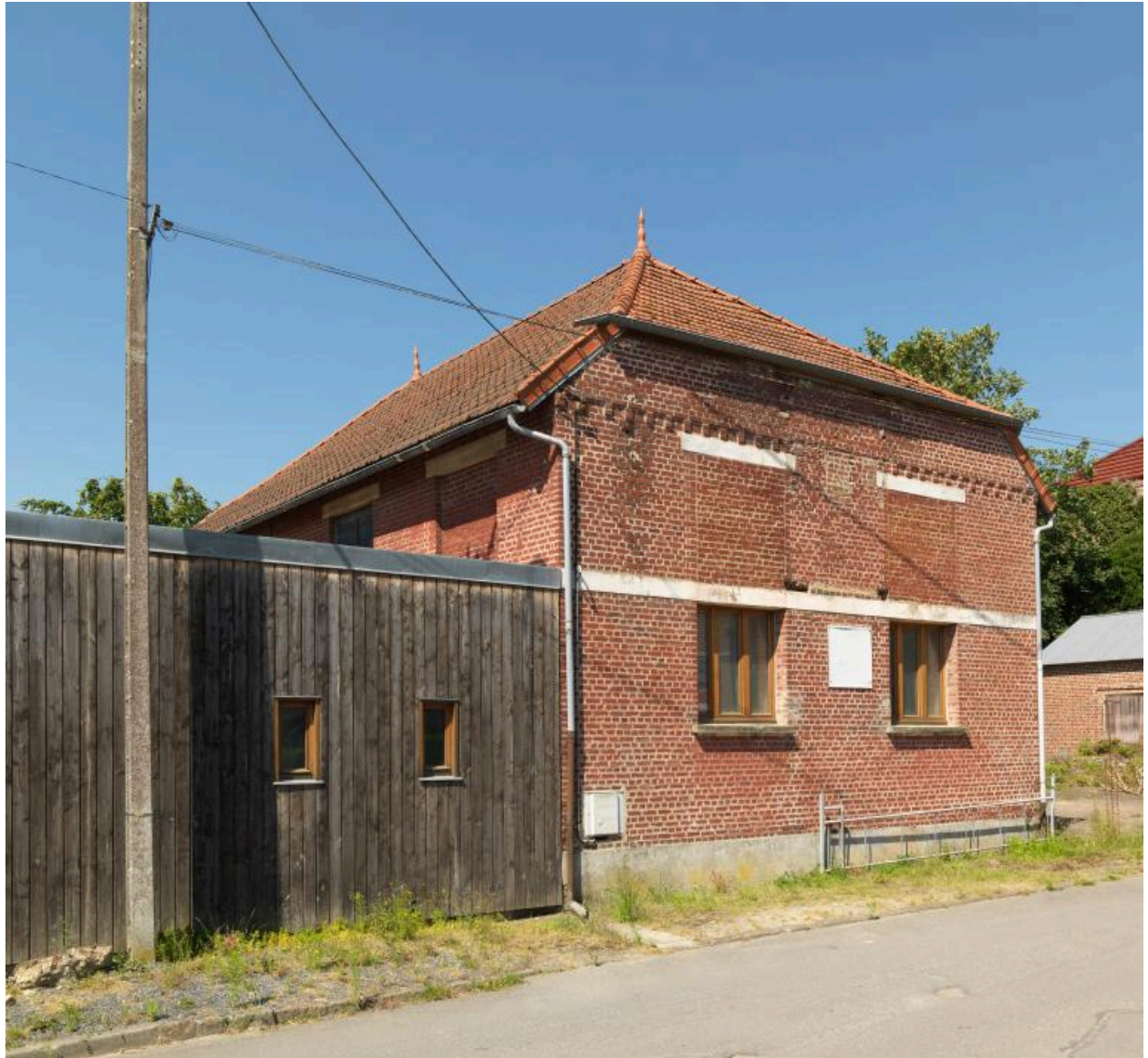
Vue de situation depuis la rue (vue sud-est).
