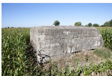
Elévation est et sud Phot. Pierre Thibaut IVR32_20165901332NUCA
