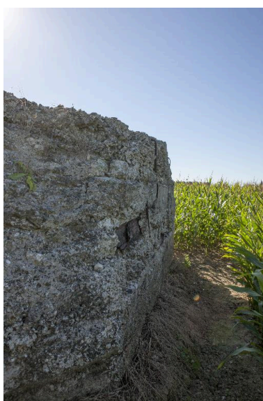
Elévation nord, vers le sud-ouest Phot. Pierre Thibaut IVR32_20165901329NUCA
