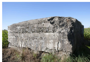
Elévations est et nord (dans l'ombre) Phot. Pierre Thibaut IVR32_20165901330NUCA
