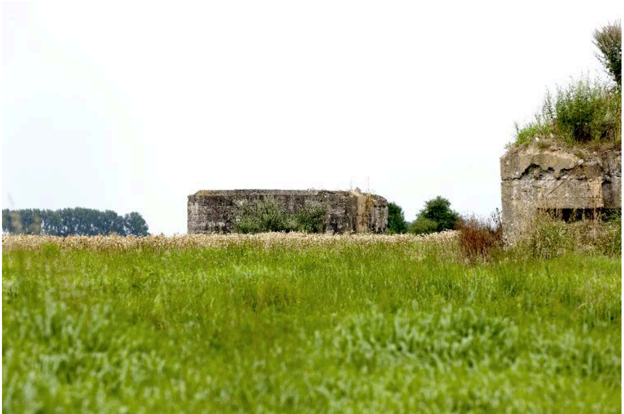
Vue générale vers le sud-ouest, depuis la route de Bas-Flandre. A droite le second poste d'artillerie de l'ensemble
