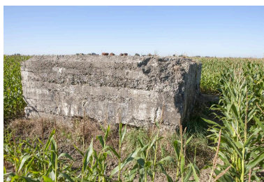
Elévations est et nord (dans l'ombre) Phot. Pierre Thibaut IVR32_20165901333NUCA
