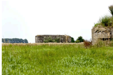
Vue générale vers le sud-ouest, depuis la route de Bas-Flandre. A droite le second poste d'artillerie de l'ensemble Phot. Jean-Marc Ramette IVR31_20145904585NUCA
