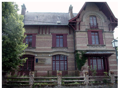
Vue d'ensemble depuis la digue. Phot. Elisabeth Justome IVR22_20038005411NUCA
