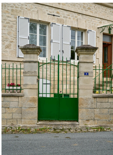
Portillon de la maison, vue sud. Phot. Thierry Lefébure IVR32_20230200119NUCA
