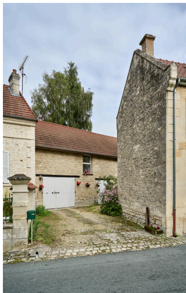
Remise de l'atelier, vue sud. Phot. Thierry Lefébure IVR32_20230200118NUCA
