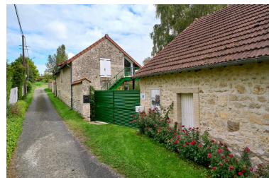
Accès à la cour de l'atelier, vue nord portail fermé. Phot. Thierry Lefébure IVR32_20230200115NUCA
