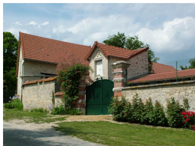
Vue des bâtiments agricoles situés à l'arrière du logis. Phot. Inès Guérin IVR22_20030203004NUCA
