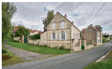
Maison et sa cour, vue ouest sur façade. Phot. Thierry Lefébure IVR32_20230200116NUCA
