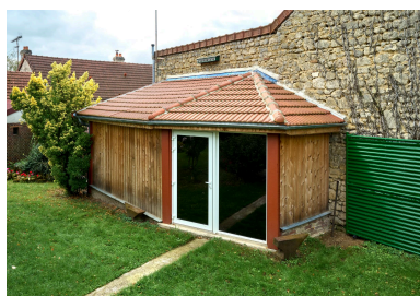
Musée de Vassogne, entrée de la partie Conservatoire des collections et accès à la grange agricole, vue est. Phot. Thierry Lefébure IVR32_20230200113NUCA
