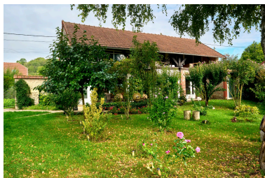
Hangar sur la cour de l'atelier, actuel bâtiment des expositions du musée de Vassogne, vue sud. Phot. Thierry Lefébure IVR32_20230200111NUCA
