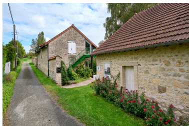
Accès à la cour de l'atelier, vue nord portail ouvert. Phot. Thierry Lefébure IVR32_20230200114NUCA
