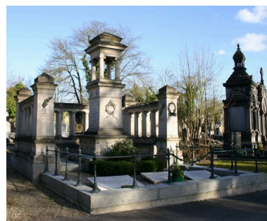
Vue générale, de trois-quarts gauche. Phot. Caroline Vincent IVR22_20088000341NUCA
