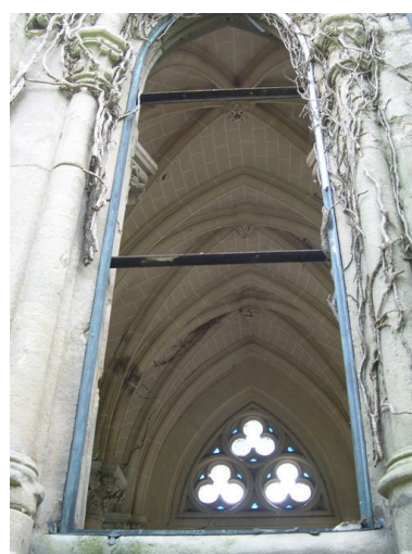
Vue de détail : voûtes. Phot. Isabelle Barbedor IVR22_20068011173NUCA
