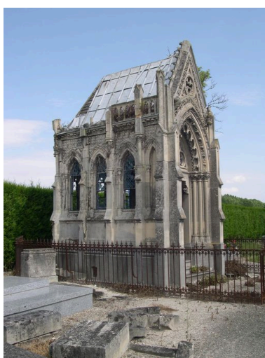
Vue de situation, depuis le sud-est. Phot. Isabelle Barbedor IVR22_20068011169NUCA
