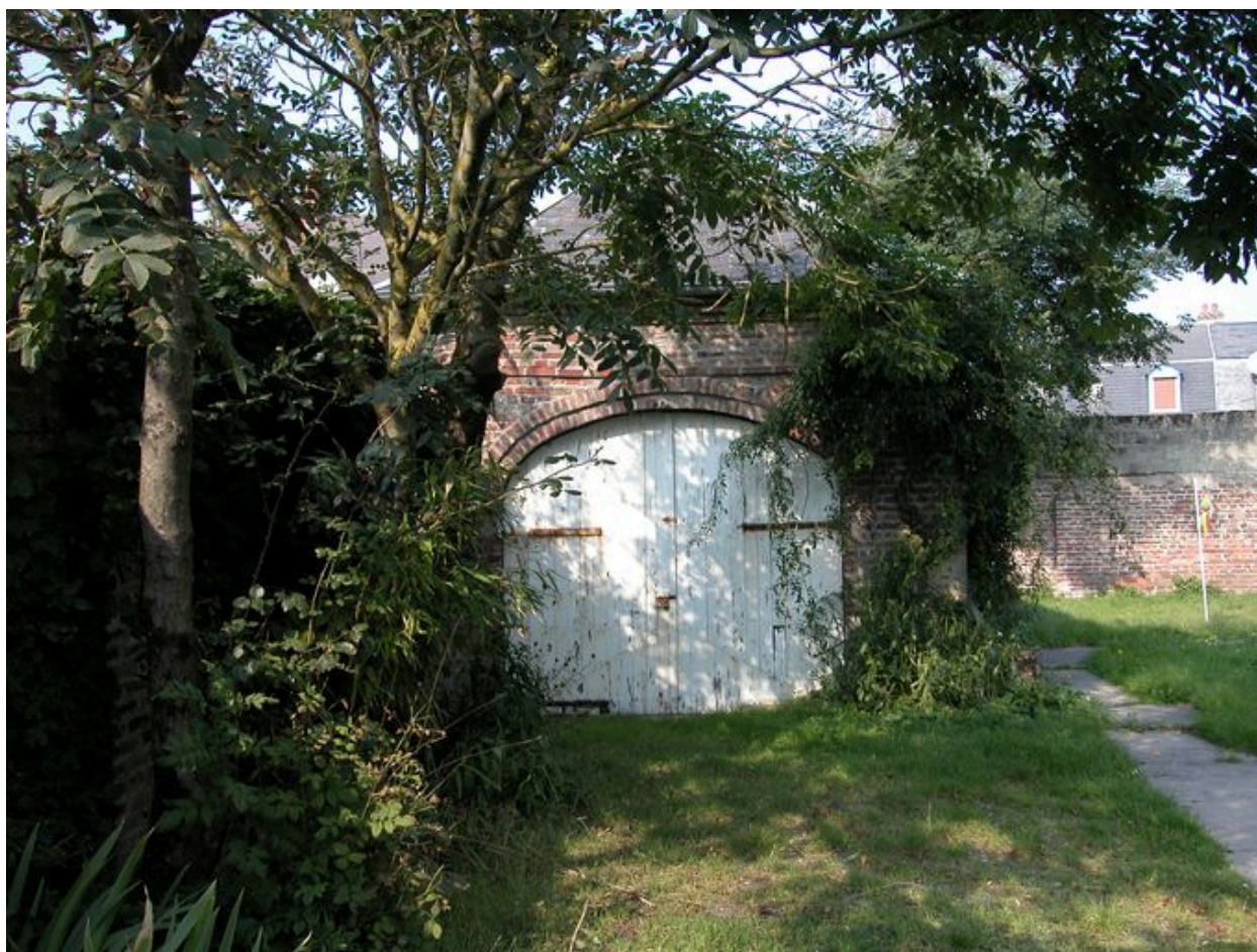
Vue du garage isolé en fond de parcelle.
