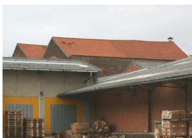
Les deux halles de 1897, vue depuis la cour de l'ancien tissage Taine, Guillot et Cie. Phot. Frédéric Pillet IVR22_20060205036NUCA
