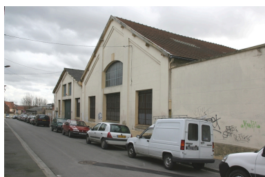
Au premier plan, pignon de la halle de fonderie de 1897. Phot. Frédéric Pillet IVR22_20060205035NUCA
