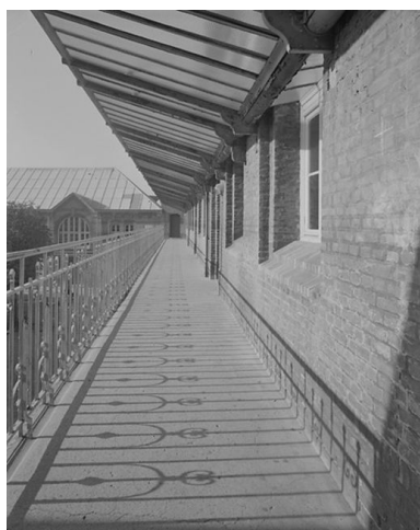
Coursière de distribution de l'étage. Phot. Thierry Lefébure IVR22_19978000709V
