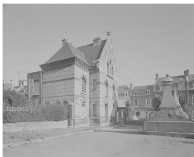
Vue de la cour d'honneur et de la conciergerie. Phot. Thierry Lefébure IVR22_19978000708V
