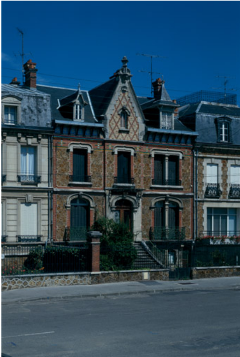
Vue générale depuis la place.
