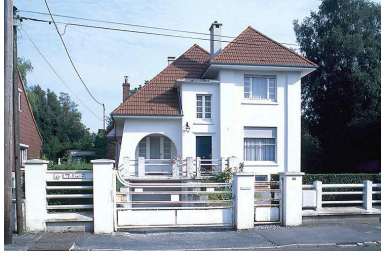
Vue générale. Phot. Thierry Petitberghien IVR31_20025902150ZA
