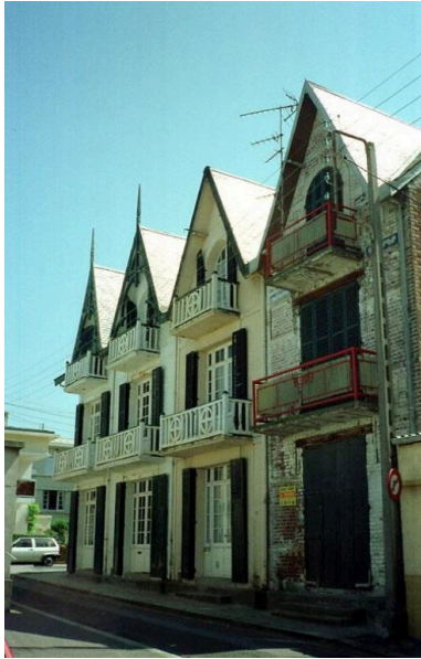
Vue générale. Phot. Richard Klein IVR31_19966201523ZE
