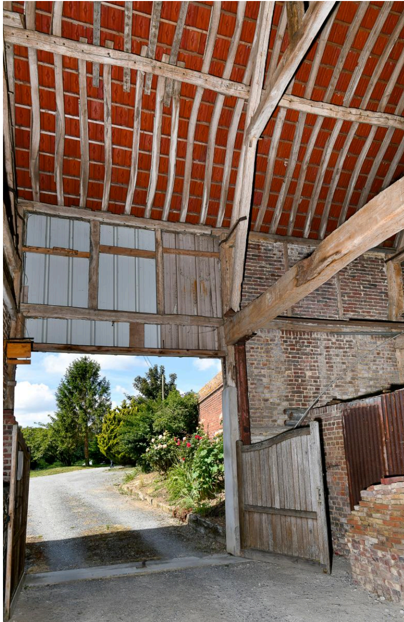
Intérieur du passage charretier, vue vers l'extérieur.
