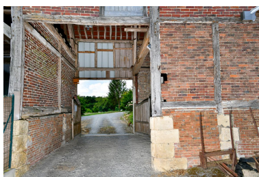
Vue de l'entrée charretière depuis la cour. Phot. Marc Kérignard IVR32_20226000461NUCA
