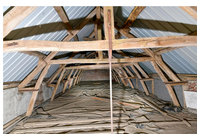
Charpente de l'étable à vaches. Phot. Marc Kérignard IVR32_20226000462NUCA
