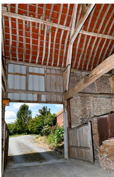
Intérieur du passage charretier, vue vers l'extérieur. Phot. Marc Kérignard IVR32_20226000460NUCA
