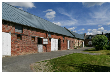
Vue générale des anciennes étables et anciennes écuries depuis le sud-est. Phot. Marc Kérignard IVR32_20226000456NUCA
