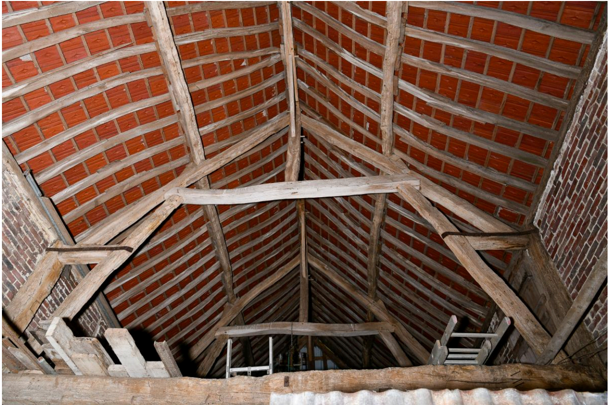
Charpente du passage charretier.
