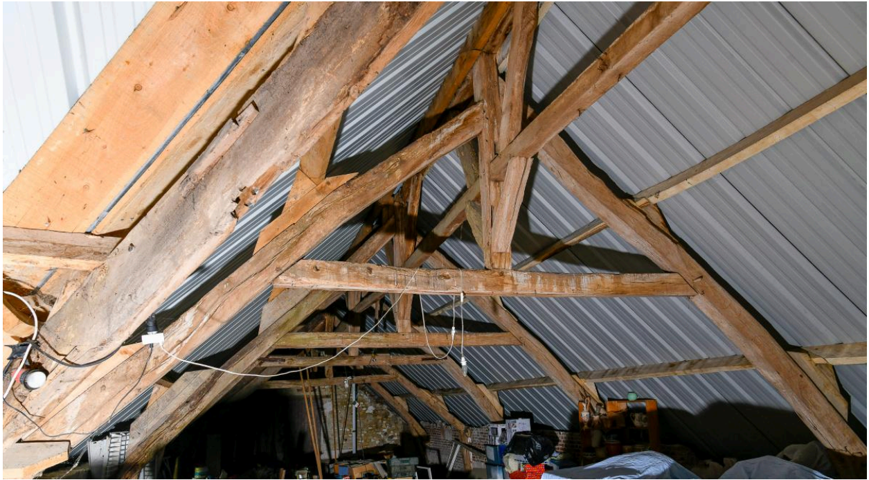
Charpente de l'ancienne écurie.
