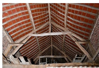
Charpente du passage charretier. Phot. Marc Kérignard IVR32_20226000459NUCA
