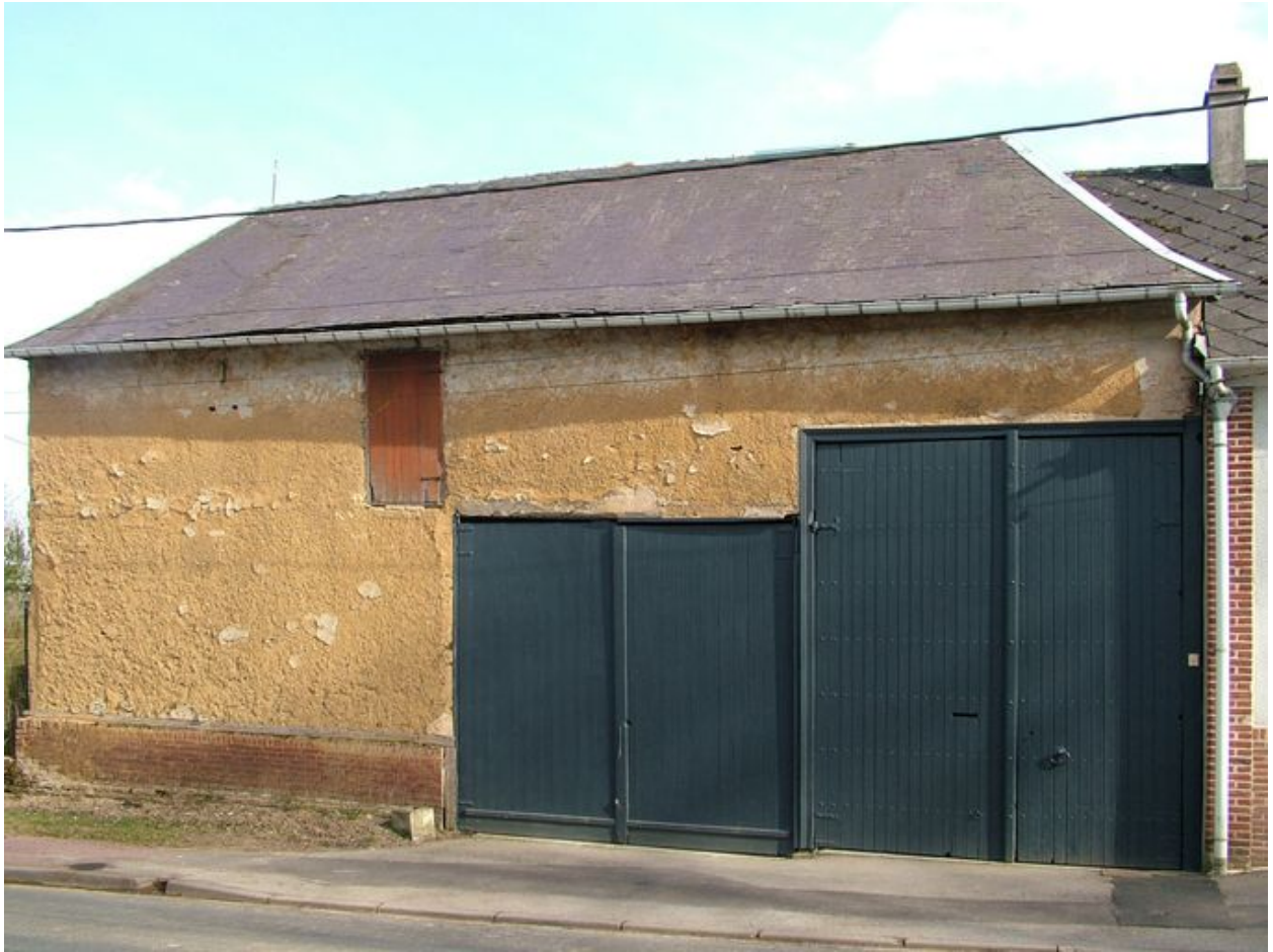
Grange et passage charretier.
