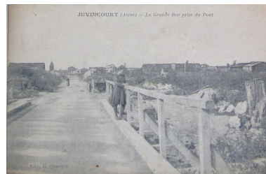
Vue de la rue principale pendant la reconstruction du village (coll. part).
