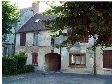
Vue d'un ensemble de maisons, dit la Cour des Miracles. Phot. Frédéric Fournis IVR22_20080290233NUC1A
