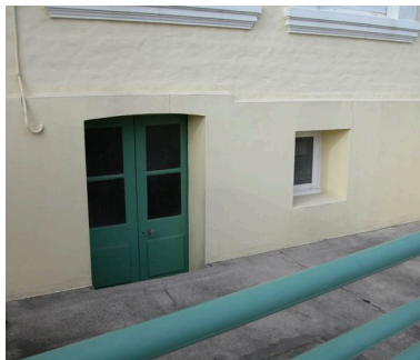
Détail de l'accès au soubassement. Phot. Elisabeth Justome IVR22_20058002628NUCA
