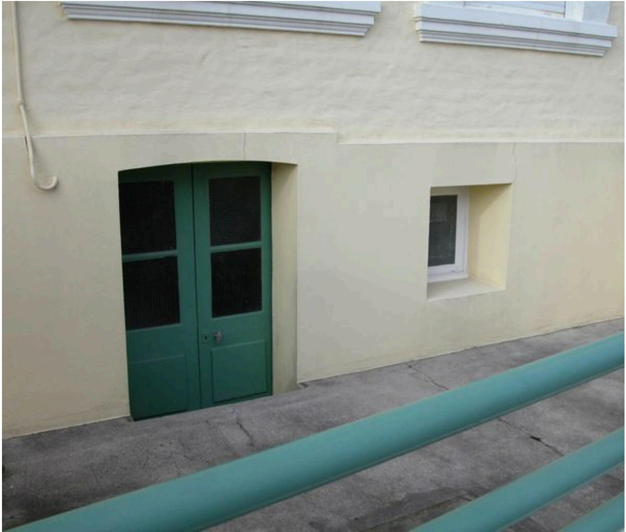
Détail de l'accès au soubassement.
