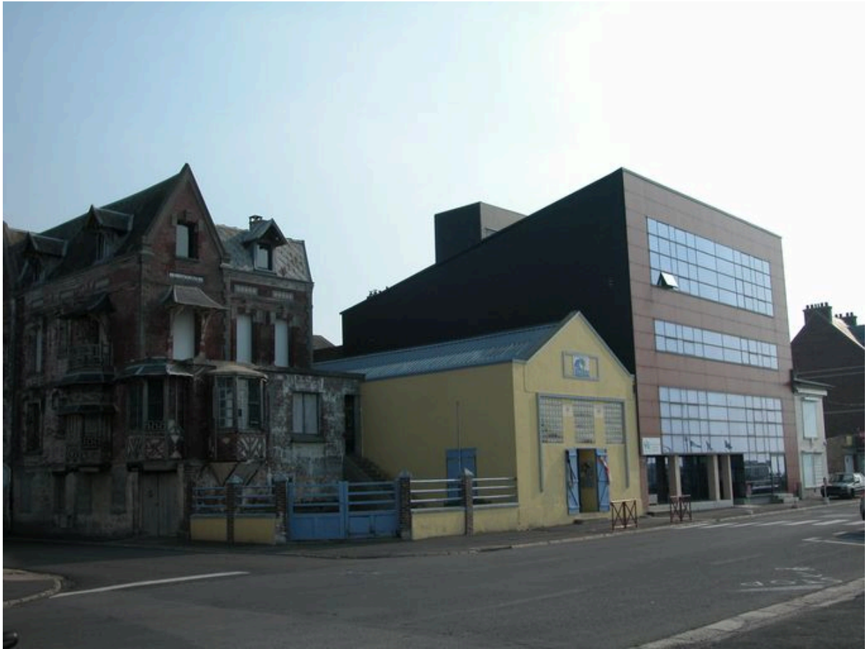
Constructions sur le front de mer.
