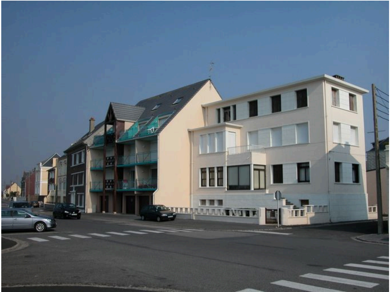
Constructions sur le front de mer.
