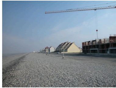
La digue de galets, le front de mer, et les constructions nouvelles du sud. Phot. Elisabeth Justome IVR22_20058003601NUCA
