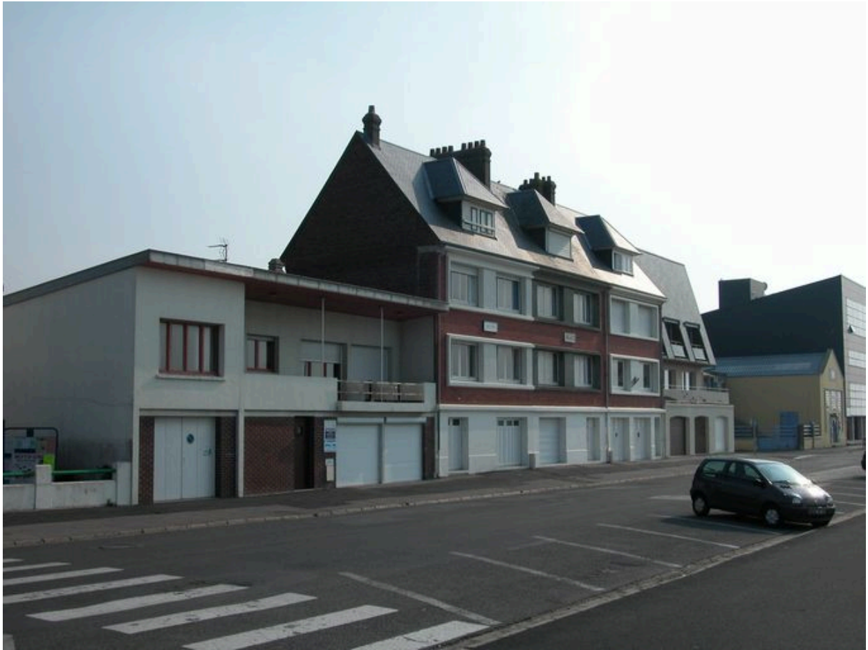
Constructions sur le front de mer.
