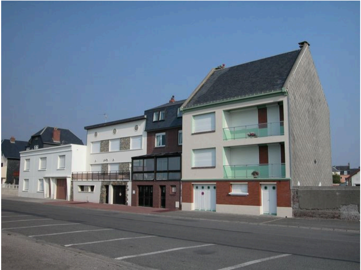
Constructions sur le front de mer.
