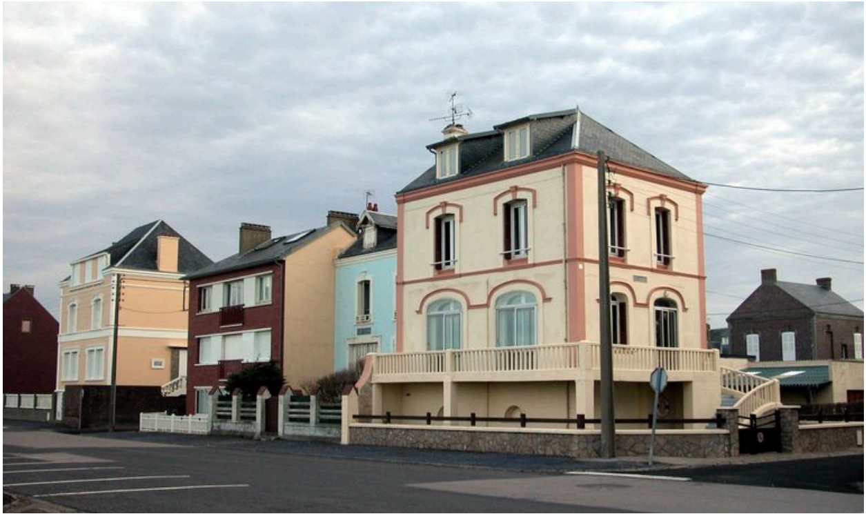
Constructions sur le front de mer.
