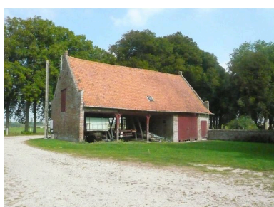
Vue de la charreterie à l'est de la propriété.
