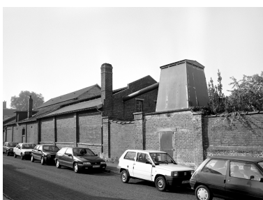
Vue latérale est-ouest des bâtiments de la menuiserie le long de la rue Caron avec, au premier plan, la chambre à copeaux. Phot. Laurent Jumel IVR22_19966002716X
