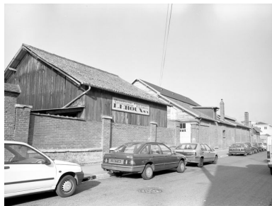
Entrée de la menuiserie rue Charles Caron, vue est-ouest. Phot. Laurent Jumel IVR22_19966002715X
