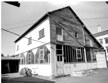
L'atelier de fabrication, pignon sud-est. Phot. Laurent Jumel IVR22_19966002720X
