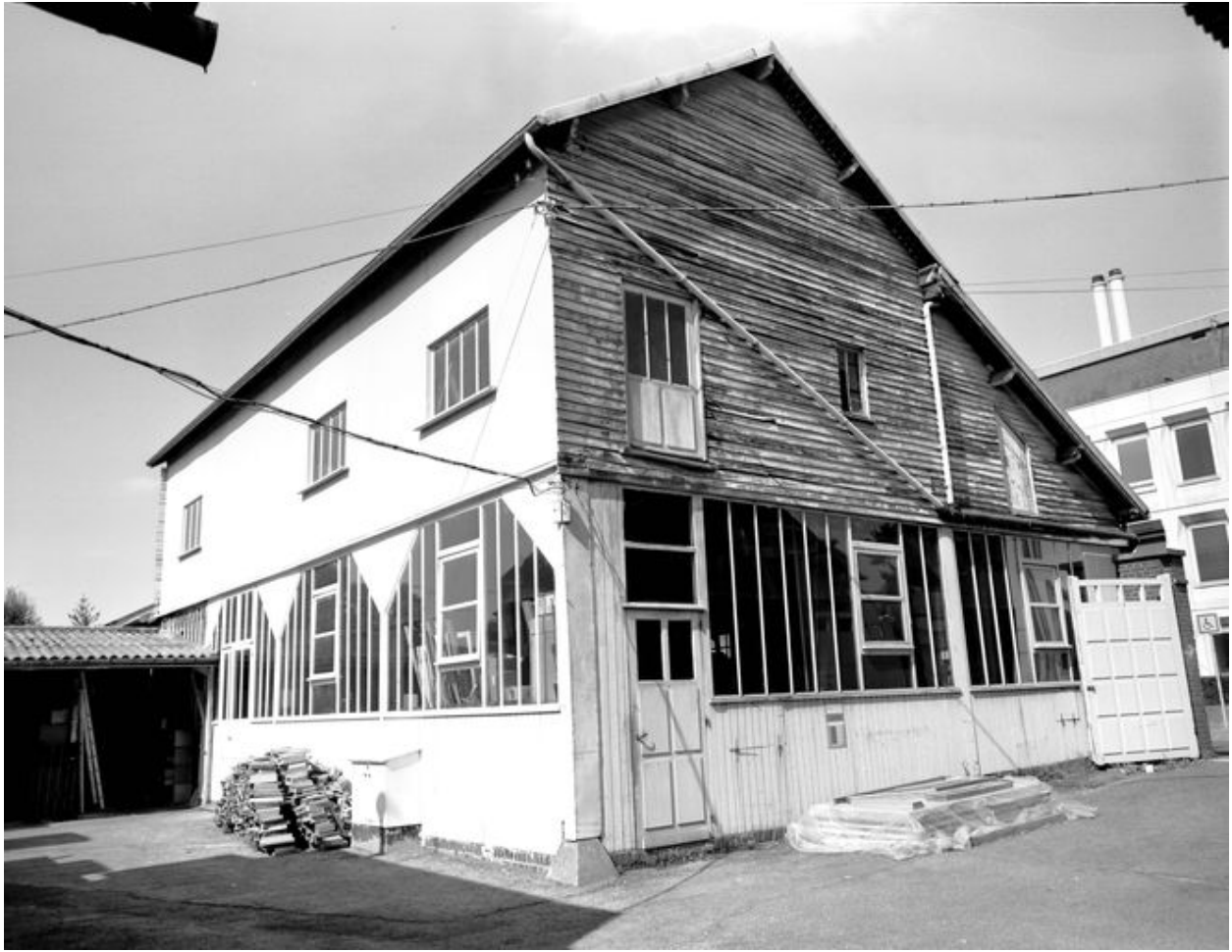
L'atelier de fabrication, pignon sud-est.
