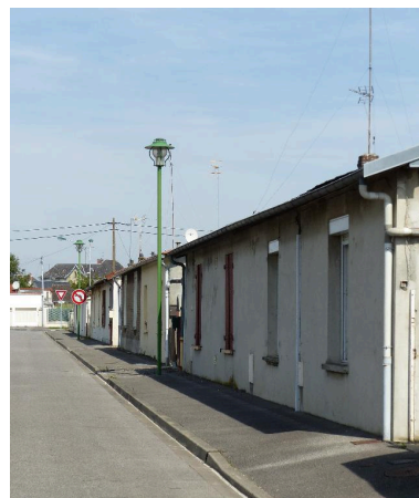
Maisons, rue d'Angleterre. Phot. Isabelle Barbedor IVR32_20170205287NUCA
