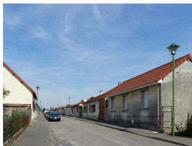
Rue de Belgique, vue depuis le sud. Phot. Isabelle Barbedor IVR32_20170205286NUCA
