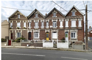
Vue générale depuis la rue du Bas Phot. Thierry Lefébure IVR22_20148000629NUC2AQ
