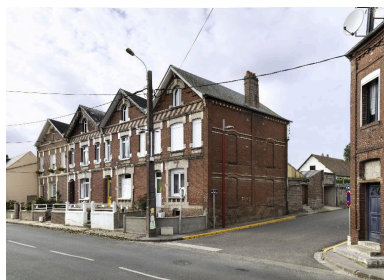
Vue de trois-quarts depuis la rue du Bas. Phot. Thierry Lefébure IVR22_20148000631NUC2A
